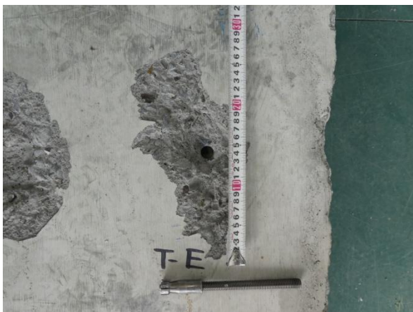
写真-6 破壊状況 試験体記号：T-E 試験項目：引張 最大荷重：21.7kN A：コーン状破壊
