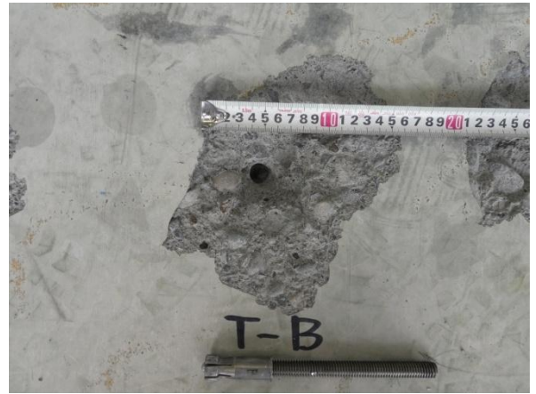
写真-3 破壊状況 試験体記号：T-B 試験項目：引張 最大荷重：24.6kN A：コーン状破壊
