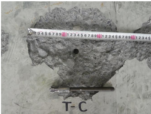
写真-4 破壊状況 試験体記号：T-C 試験項目：引張 最大荷重：23.1kN A：コーン状破壊
