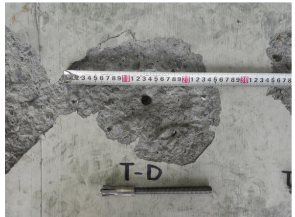
写真-5 破壊状況 試験体記号：T-D 試験項目：引張 最大荷重：23.4kN A：コーン状破壊
